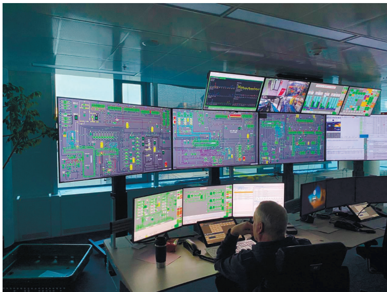
In der Computerabteilung des Flughafens / В компьютерном зале аэропорта
