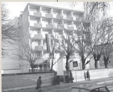
Einweihung des Alten- und Pflege- heims (erster Bauabschnitt)
