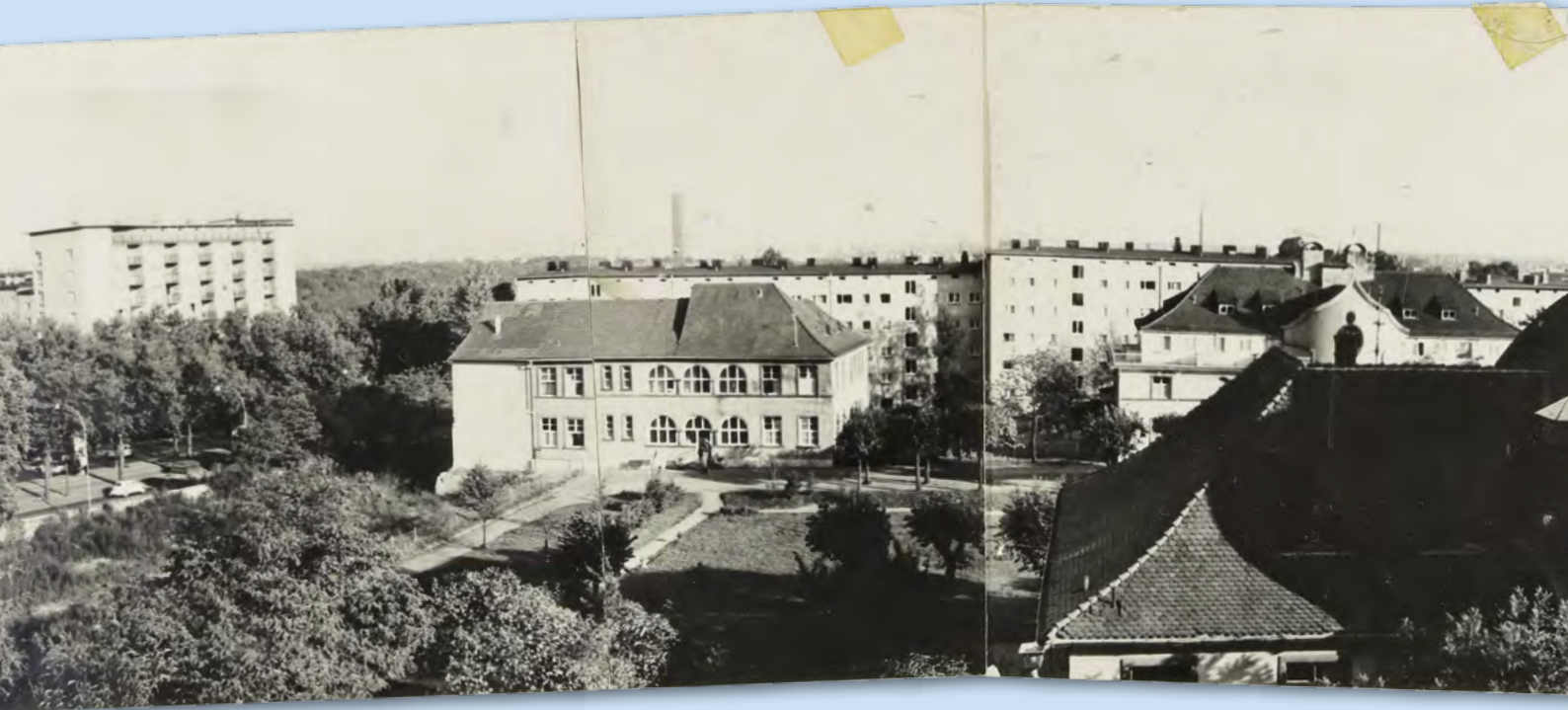
Abb. 14: Die Gebäude des Israelitischen Krankenhauses mit dem Portalbau im Zentrum, ca. 1970.
