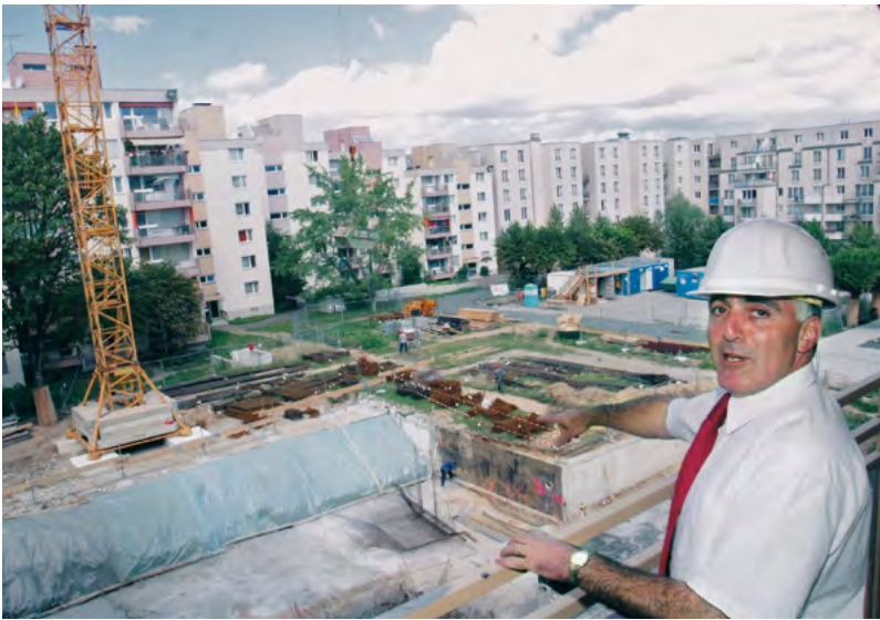
Abb. 5: Heimleiter Leo Friedman klärt über den Stand der Bauarbeiten auf, 2004
